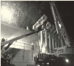
道路改築事業細谷第4ロックキーパー （平成24年）
