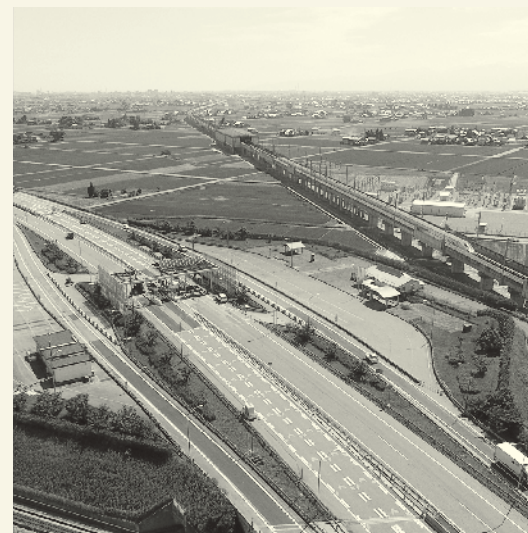
福岡本線料金所撤去工事 (平成30年6月22日撮影)
