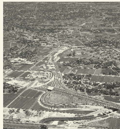
高岡インターチェンジ
