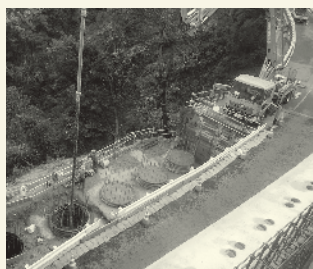
道路改築事業細谷第1ロックシェッド (平成30年)
