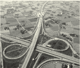
小矢部ジャンクション 小矢部東本線料金所整備後（平成16年）
