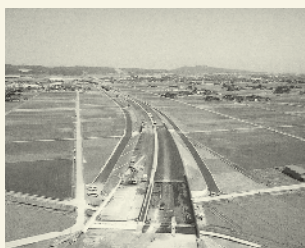
北進する能越自動車道の舗装工事
