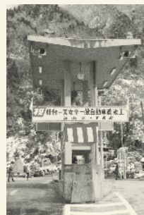
竣工した桂台料金所 (昭和 45 年)
