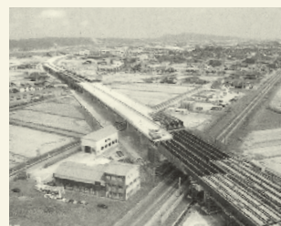
JR北陸本線を跨ぐ能越自動車道
