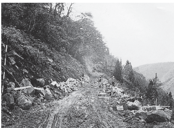
桂台～美女平間の道路工事(昭和43年頃)
