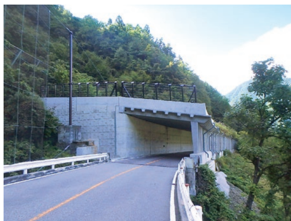
細谷第1ロックシェッド(令和2年)
