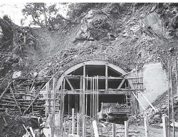
恒性寺トンネル工事(昭和43年頃)
