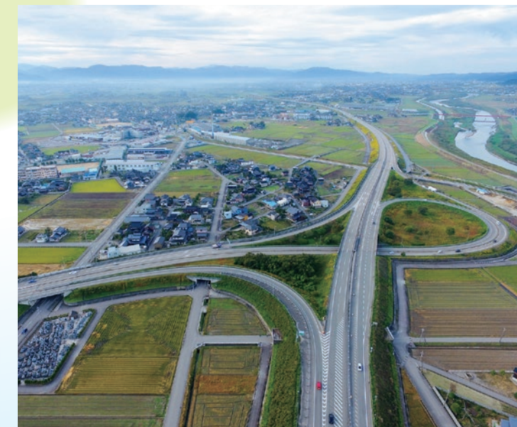
高岡インターチェンジ
