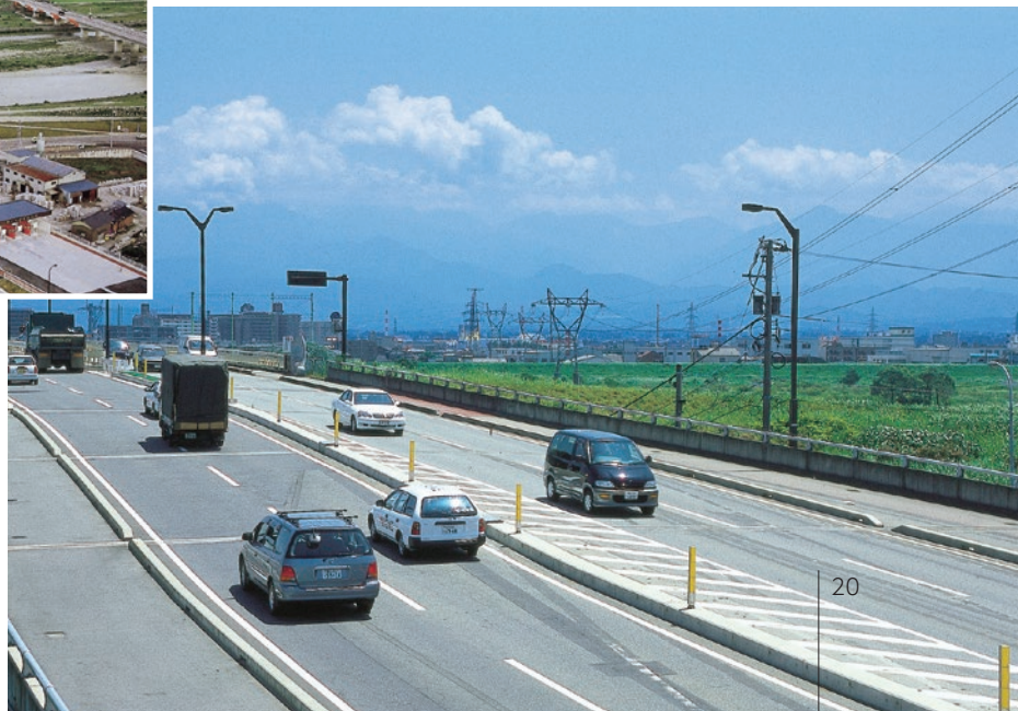
4車線化になった現在の婦中大橋
