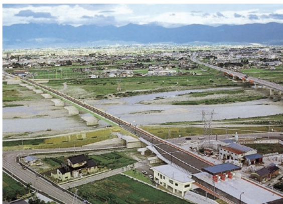
開通直後の婦中大橋有料道路
